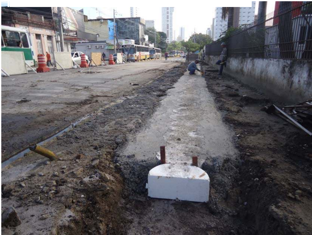
Figura 66 - Gabarito para cravar as estacas de sustentação do Túnel.
