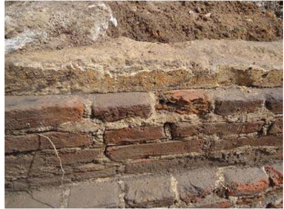
Figura 99 - Detalhe da ES 06 com reboco. Fonte: Acervo fotográfico da Arqueolog Pesquisas.
