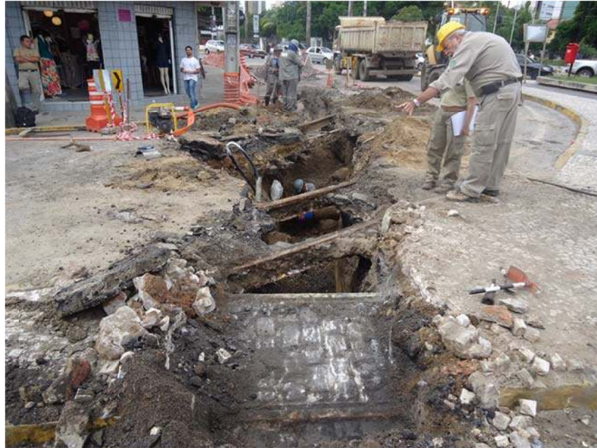
Figura 108 - Panorâmica da localização das 03 linhas do bonde no cruzamento da Rua Real da Torre com Av. Caxangá, ES 07. Fonte: Acervo fotográfico da Arqueolog Pesquisas.
