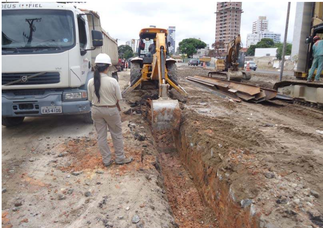
Figura 60 - Monitoramento Arqueológico da ampliação nas laterais das estacas cravadas na Vala 05. Fonte: Acervo fotográfico da Arqueolog Pesquisas.
