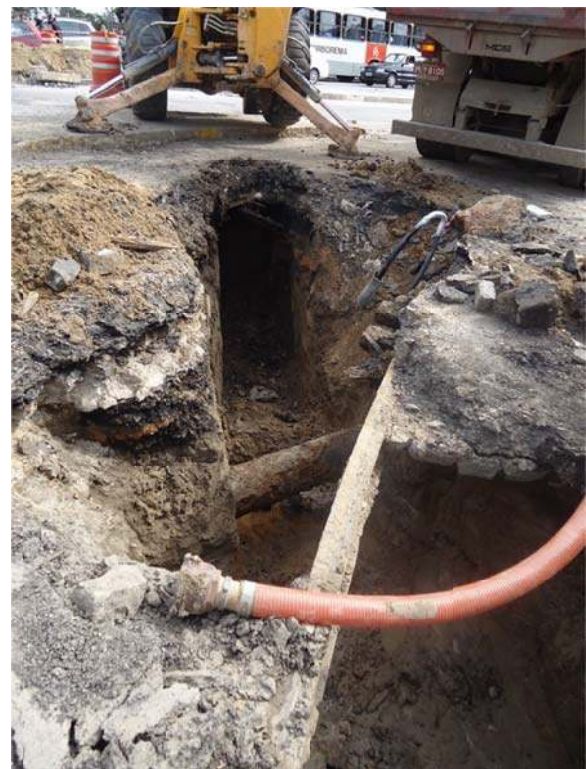
Figura 110 - Tubulação da Compesa abaixo da linha do bonde, ES 07. Fonte: Acervo fotográfico da Arqueolog Pesquisas.
