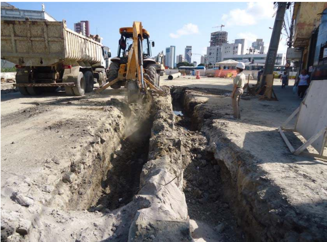
Figura 150 - Monitoramento Arqueológico da ampliação nas laterais das estacas cravadas na Vala 07. Fonte: Acervo fotográfico da Arqueolog Pesquisas.
