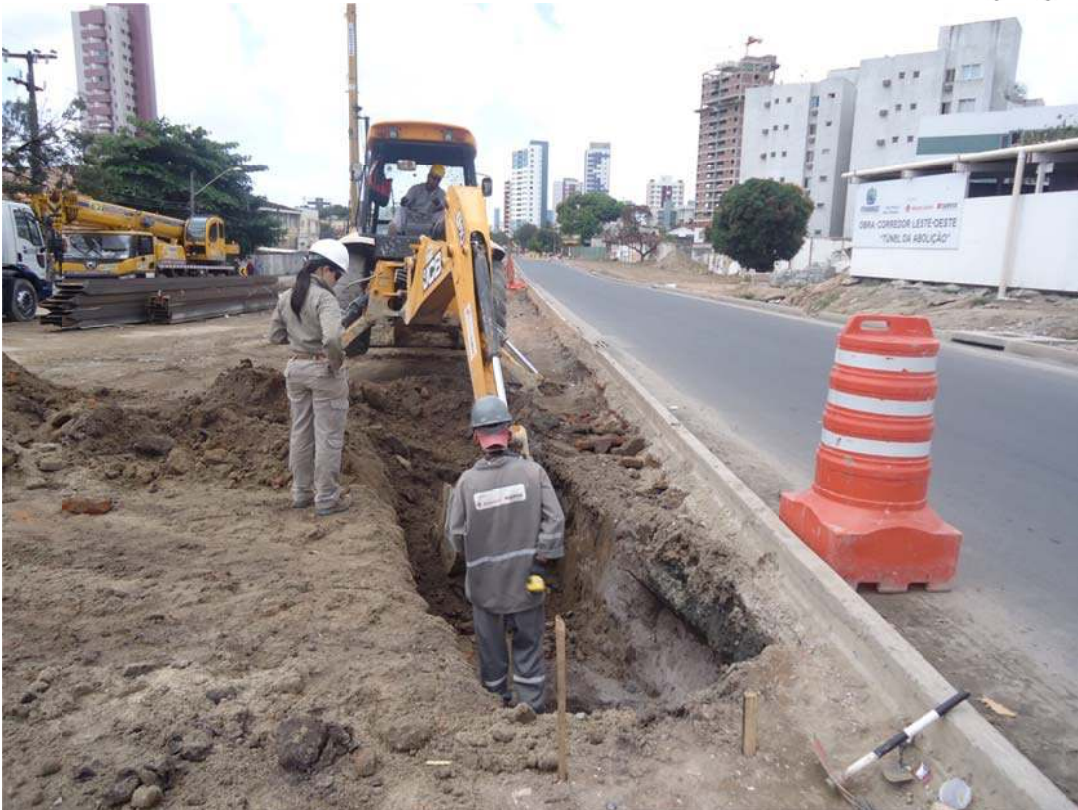
Figura 149 - Monitoramento Arqueológico da continuação da abertura da Vala 07. Fonte: Acervo fotográfico da Arqueolog Pesquisas.
