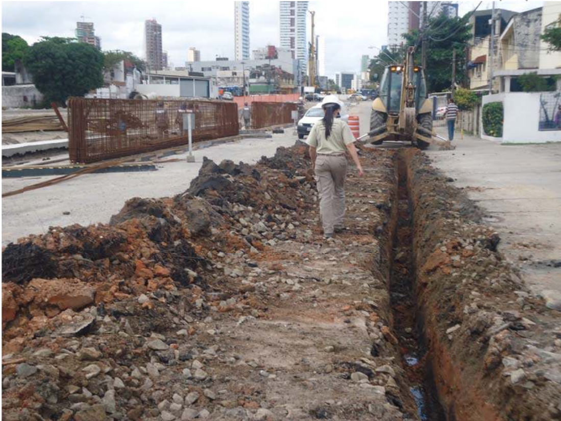
Figura 159 - Vistoria de superfície na Vala 08. Fonte: Acervo fotográfico da Arqueolog Pesquisas.
