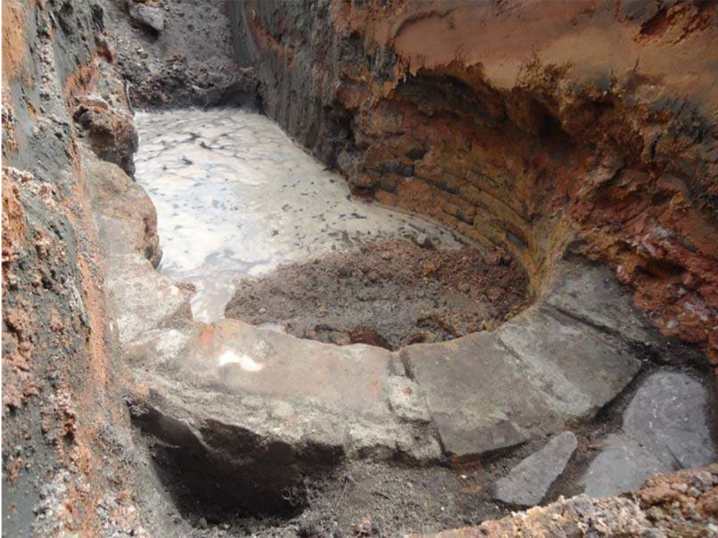
Figura 49 - Detalhe do reboco na parte externa na ES 14. Fonte: Acervo fotográfico da Arqueolog Pesquisas.
