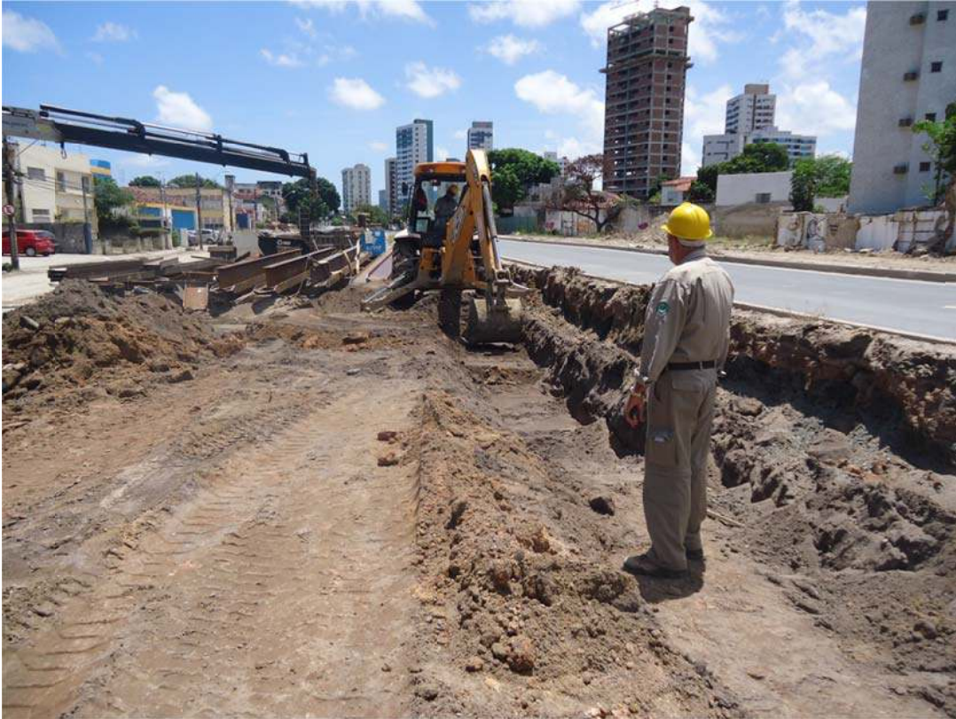
Figura 151 - Monitoramento Arqueológico da continuação da abertura da Vala 07. Fonte: Acervo fotográfico
