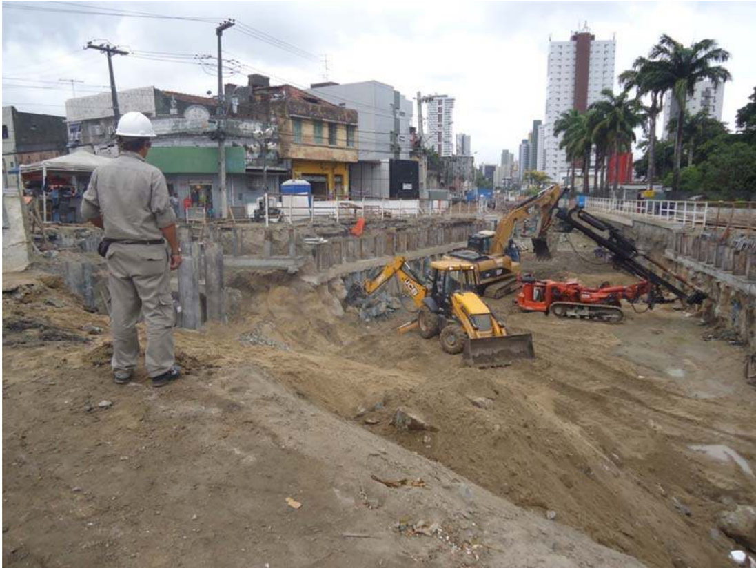
Figura 172 - Panorâmica da Escavação do Túnel da Abolição. Fonte: Acervo fotográfico da Arqueolog Pesquisas.
