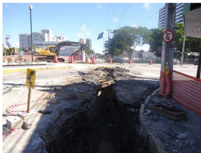
Figura 105 - Panorâmica do segundo ponto de localização das linhas do bonde na Rua Real da Torre, ES 07. Fonte: Acervo fotográfico da Arqueolog Pesquisas.
