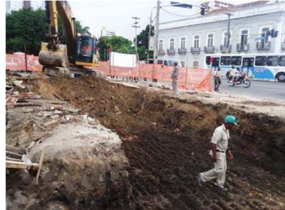
Figura 78 - Vistoria de superfície após o corte/terraplanagem. Fonte: Acervo fotográfico da Arqueolog Pesquisas.
