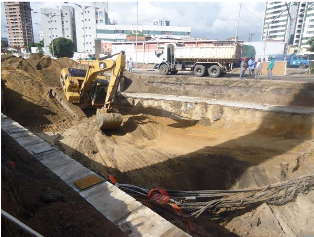
Figura 181 - Monitoramento Arqueológico da escavação e instalação do Túnel da Abolição no Cruzamento da Rua Real da Torre com a Av. Caxangá. Fonte: Acervo fotográfico da Arqueolog
