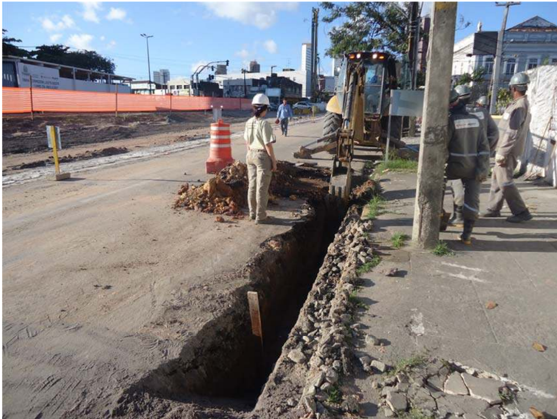
Figura 158- Monitoramento Arqueológico início da abertura da Vala 08. Fonte: Acervo fotográfico da Arqueolog Pesquisas.
