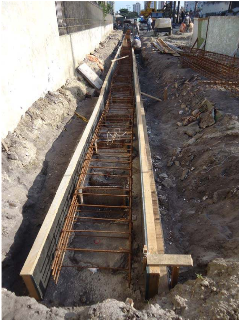
Figura 70 – Armação em ferro para concretar a coroa na Vala 05. Fonte: Acervo fotográfico da Arqueolog Pesquisas.
