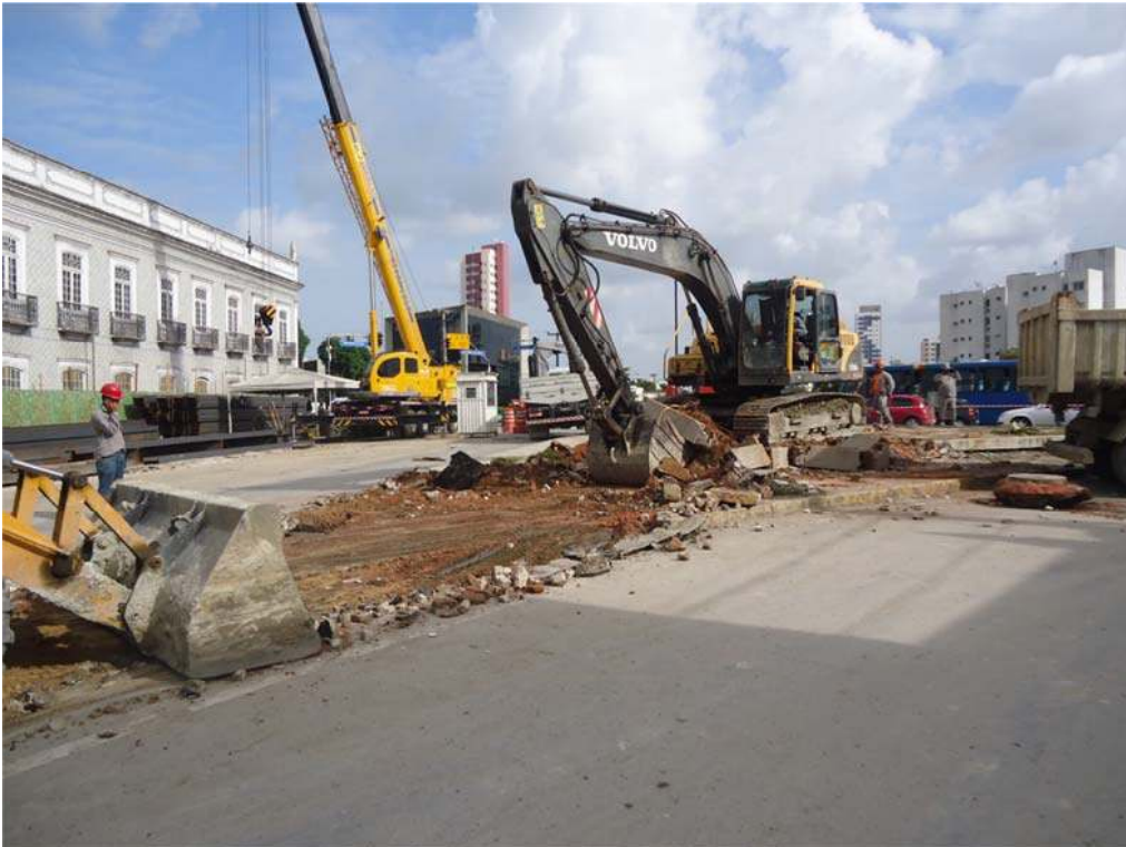
Figura 132 - Monitoramento arqueológico da demolição da Praça João Alfredo. Fonte: Acervo fotográfico da Arqueolog Pesquisas.
