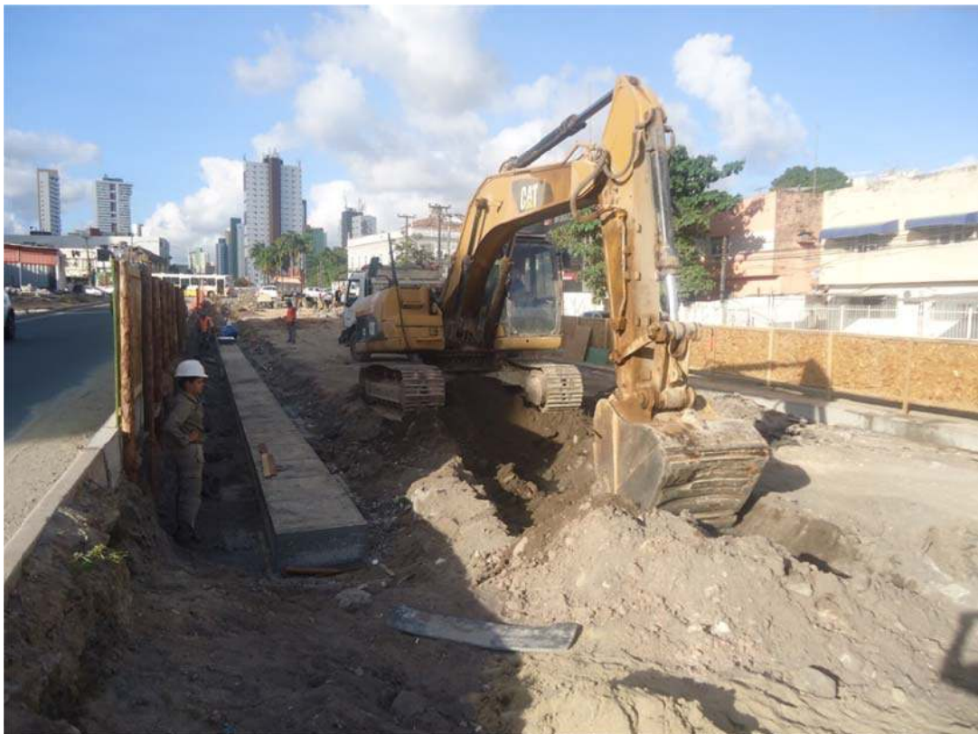
Figura 175 - Monitoramento Arqueológico na abertura do Túnel da Abolição. Fonte: Acervo fotográfico da Arqueolog Pesquisas.
