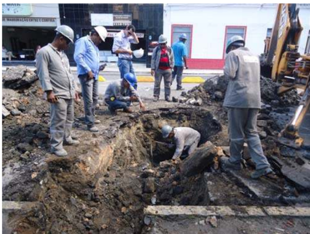
Figura 61 - Corte realizado para localizar a Adutora. Fonte: Acervo fotográfico da Arqueolog Pesquisas.
