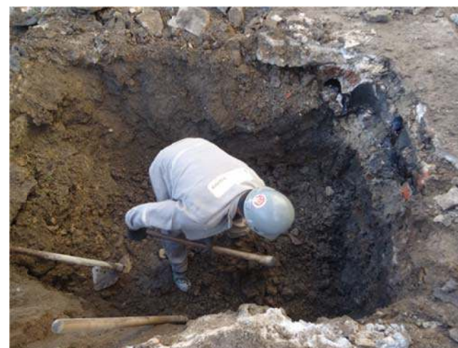
Figura 64 - Finalização da abertura do corte para implantação da fossa provisória. Fonte: Acervo fotográfico da Arqueolog Pesquisas.
