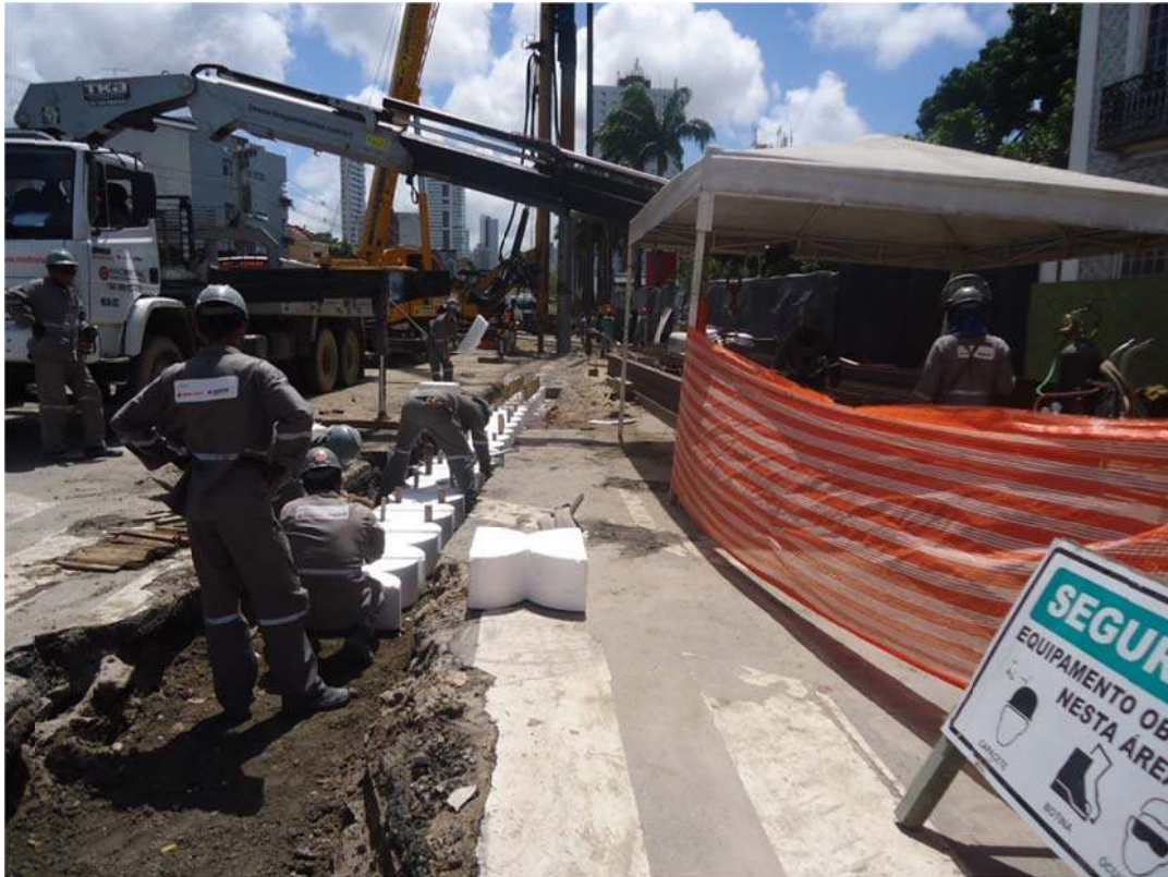
Figura 65 - Gabarito para cravar as estacas de sustentação do Túnel.
