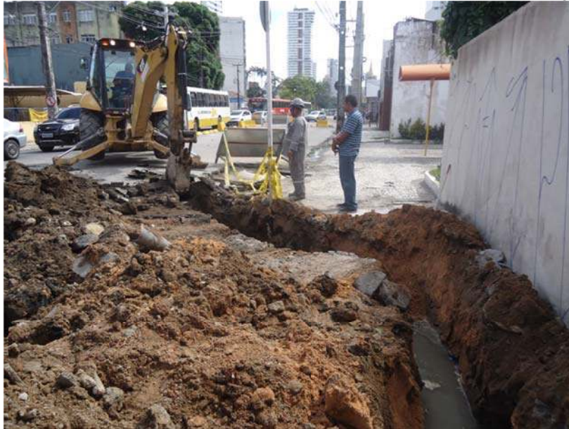
Figura 73 - Monitoramento Arqueológico da Vala 06, no momento em que se torna perpendicular. Fonte: Acervo fotográfico da Arqueolog Pesquisas.
