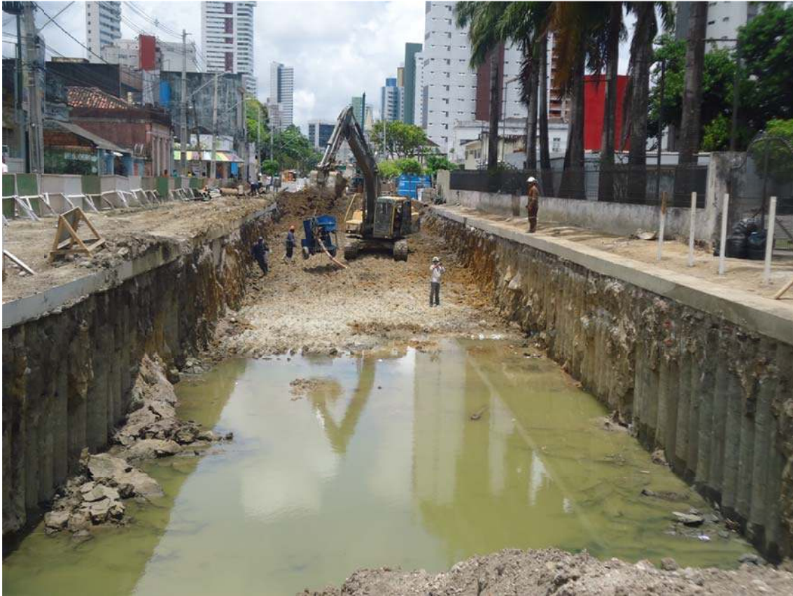
Figura 169 - Panorâmica da Escavação do Túnel da Abolição. Fonte: Acervo fotográfico da Arqueolog Pesquisas.
