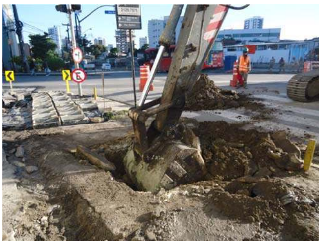
Figura 63 - Monitoramento da abertura do corte para implantação da fossa provisória. Fonte: Acervo fotográfico da Arqueolog Pesquisas.
