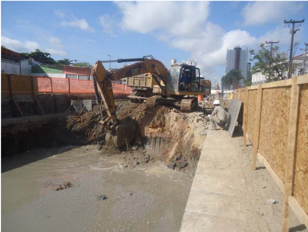
Figura 176 - Monitoramento Arqueológico da escavação e instalação do Túnel da Abolição na Rua João Ivo da Silva. Fonte: Acervo fotográfico da Arqueolog Pesquisas.
