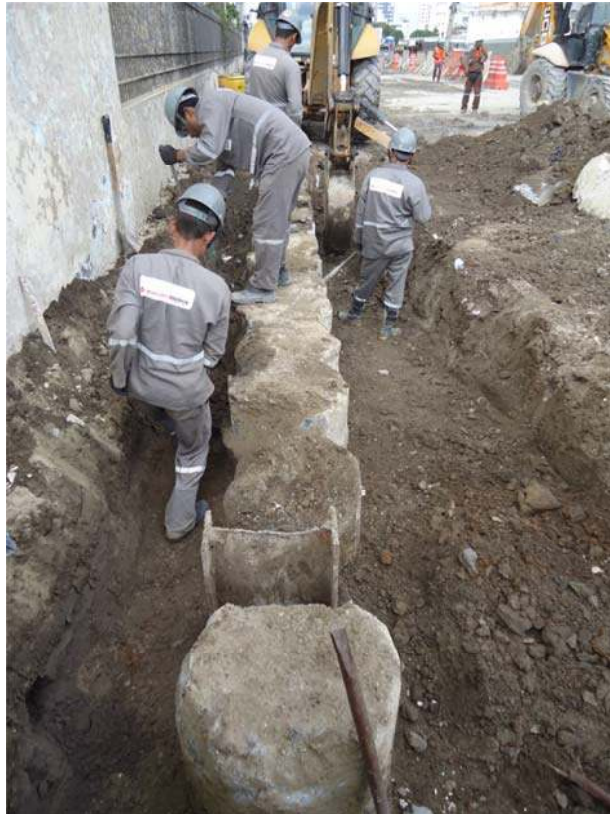
Figura 67 - Ampliação nas laterais das estacas secante na Vala 05. Fonte: Acervo fotográfico da Arqueolog Pesquisas.
