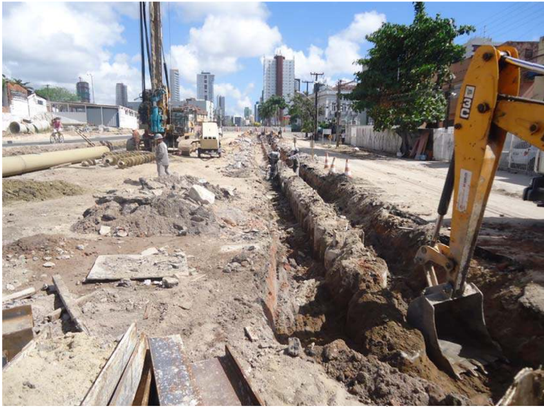
Figura 59 - Panorâmica da ampliação nas laterais das estacas cravadas na Vala 05. Fonte: Acervo fotográfico da Arqueolog Pesquisas.
