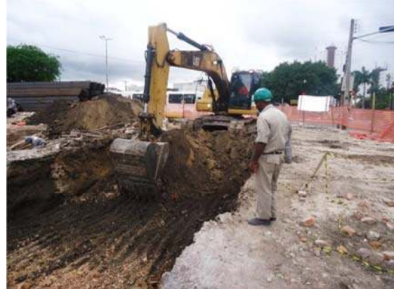
Figura 76 - Acompanhamento do corte/terraplanagem na Área 02. Fonte: Acervo fotográfico da Arqueolog Pesquisas.
