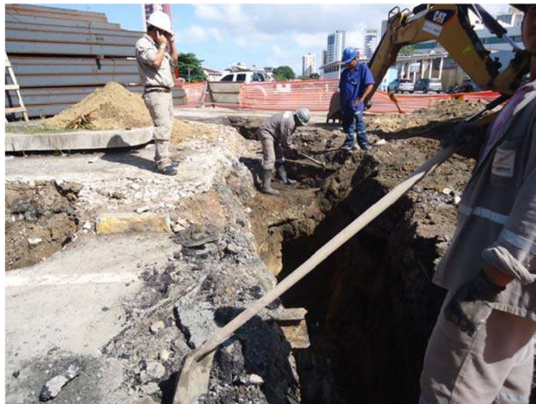
Figura 131 - Monitoramento Arqueológico da ampliação dos C 09 e C 10 para remoção de parte da tubulação da adutora. Fonte: Acervo fotográfico da Arqueolog Pesquisas.
