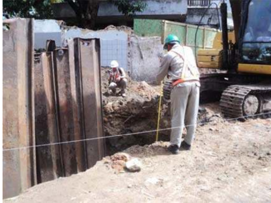
Figura 75 - Medição da profundidade da Vala 02. Fonte: Acervo fotográfico da Arqueolog Pesquisas.
