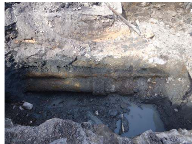
Figura 62 - Localização da Adutora para ser seccionada. Fonte: Acervo fotográfico da Arqueolog Pesquisas.
