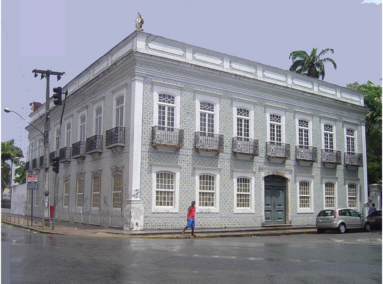
Figura 7 – Casarão de João Alfredo na Madalena.
