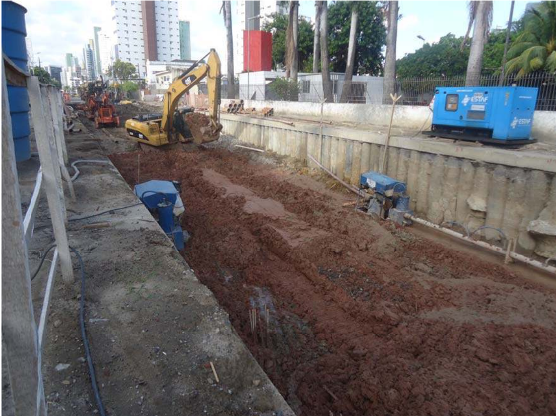
Figura 182 - Monitoramento Arqueológico da remoção da lama após período chuvoso, na área de implantação do Túnel da Abolição. Fonte: Acervo fotográfico da Arqueolog Pesquisas.
