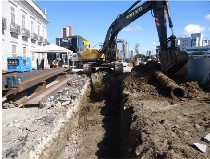
Figura 32 - Ampliação da Vala 05 para remoção de parte da tubulação da adutora. Fonte: Acervo fotográfico da Arqueolog Pesquisas.
