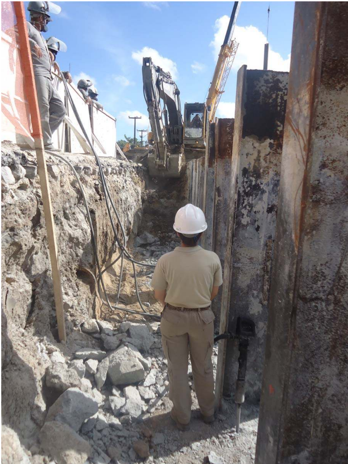
Figura 69 - Monitoramento Arqueológico da ampliação nas laterais das estacas cravadas na Vala 05. Fonte: Acervo fotográfico da Arqueolog Pesquisas.
