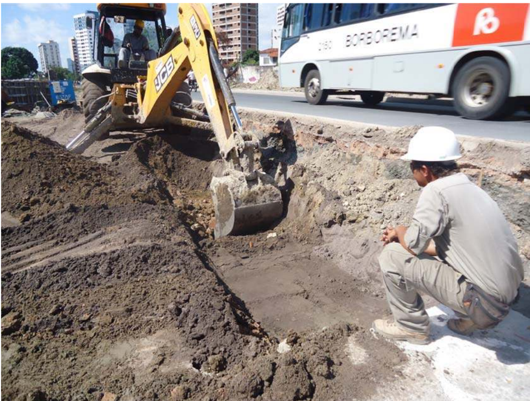
Figura 152 - Monitoramento Arqueológico da continuação da abertura da Vala 07. Fonte: Acervo fotográfico
