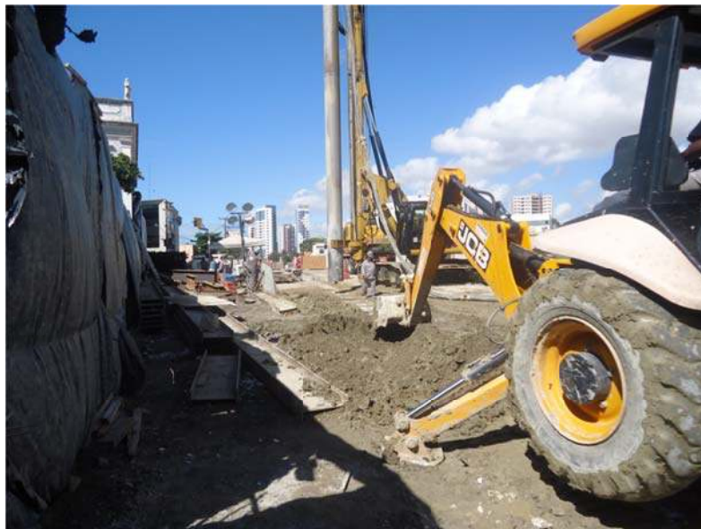
Figura 68 - Monitoramento Arqueológico da perfuração implantação da estaca secante. Fonte: Acervo fotográfico da Arqueolog Pesquisas.
