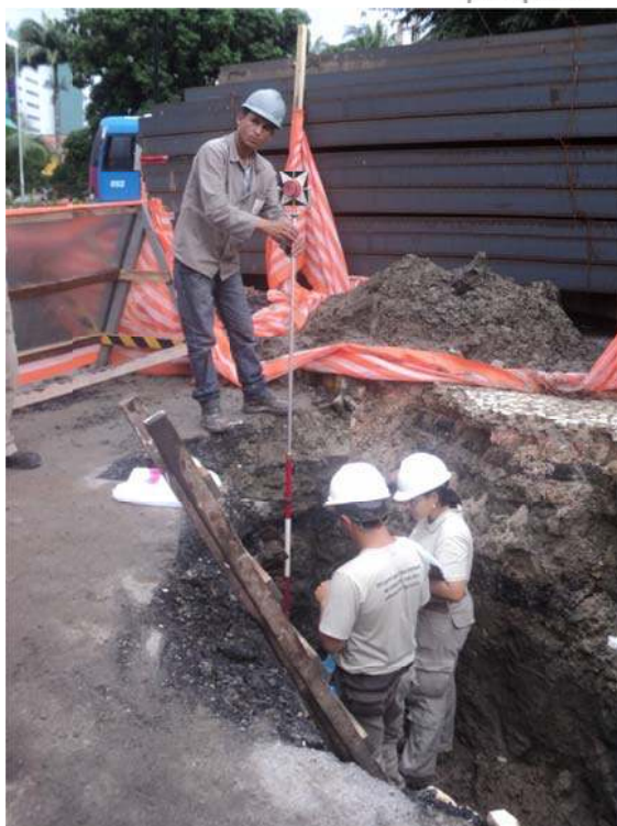
Figura 116 - Levantamento topográfico confirmando que o sepultamento esta fora da área do Túnel da Abolição. Fonte: Acervo fotográfico da Arqueolog Pesquisas.
