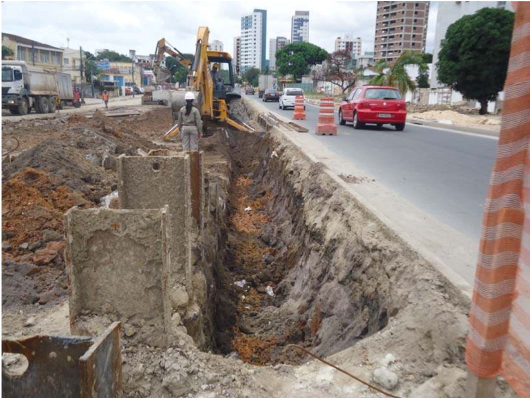
Figura 153 - Monitoramento Arqueológico da ampliação nas laterais das estacas cravadas na Vala 07. Fonte: Acervo fotográfico da Arqueolog Pesquisas.
