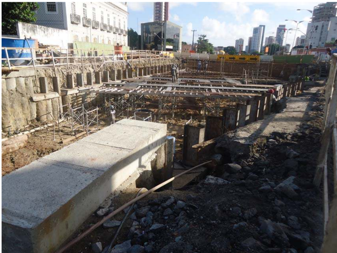
Figura 183 - Armação das Vigas de sustentação da futura praça. Fonte: Acervo fotográfico da Arqueolog Pesquisas.
