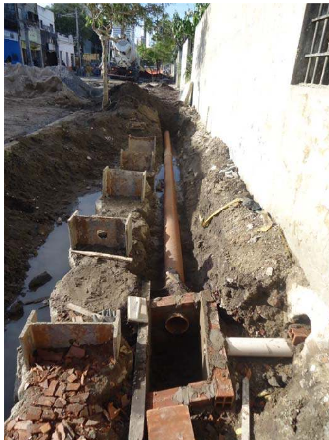
Figura 74 - Implantação na tubulação de esgoto na Vala 06. Fonte: Acervo fotográfico da Arqueolog Pesquisas.
