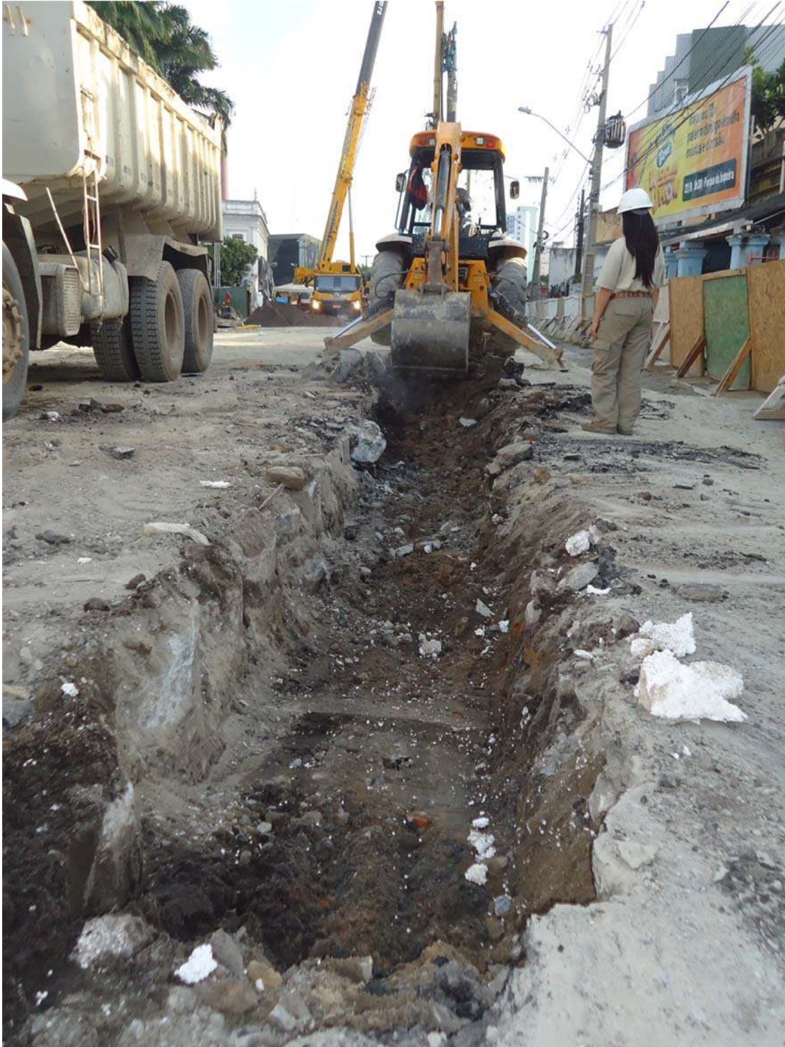
Figura 148 - Ampliação nas laterais das estacas cravadas na Vala 07. Fonte: Acervo fotográfico da Arqueolog Pesquisas.
