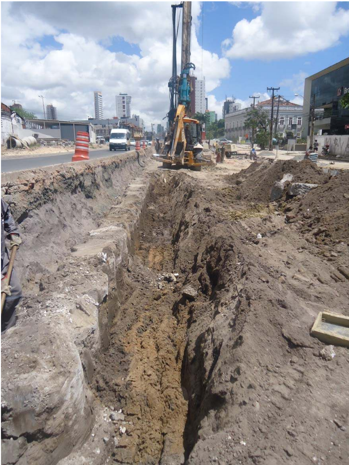
Figura 154 - Panorâmica da ampliação nas laterais das estacas cravadas na Vala 07. Fonte: Acervo fotográfico da
